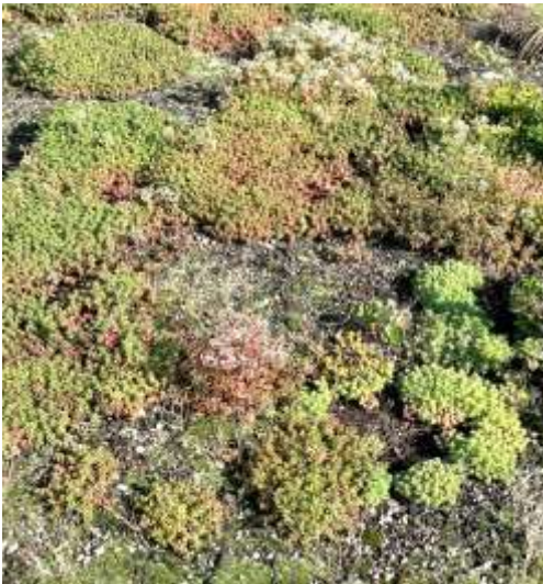
Geschädigte Dachbegrünung durch Wurzelfraß von Insektenlarven (links); Larve von Wiesenschnaken frisst oft an Pflanzenwurzeln
