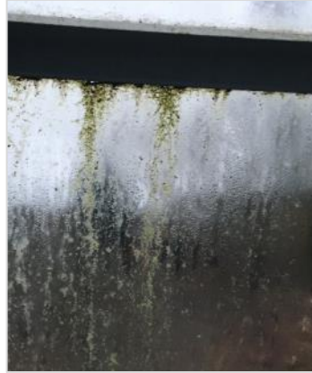
Von Innen verschmutzte Gewächshaussscheiben mindern die Lichtdurchlässigkeit
